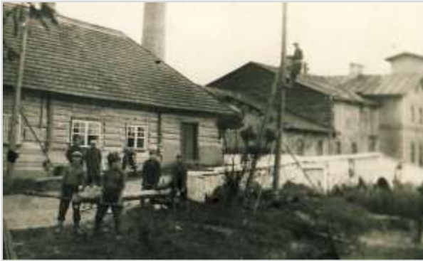
Foto 48. Telefoniliini remont Undla veski juures, vasakul vesiveski. 164 Foto on dateerimata, kuid arvatavalt 1930. aastad.
